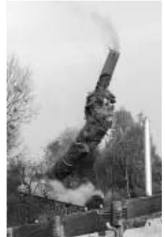
Bohrlöcher mit einer Tiefe von 85 cm angelegt werden, in denen die 8,9 kg Sprengstoff verteilt wurden. Die anschließende Sprengung erfolgte, wie von den Sprengmeistern berechnet, punktgenau.
