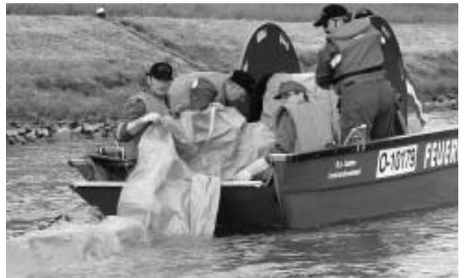
Zuerst wurde eine Sperre ausgelegt, dann mit einer Seilwinde zu einer sackförmigen Schlaufe gezogen und am Ufer befestigt. Mit der nächsten Ölsperre kam man schon näher ans Ufer und mit der dritten gelang es, das ausgetretene Öl ans Ufer zu bringen und somit ein Absaugen zu ermöglichen.
