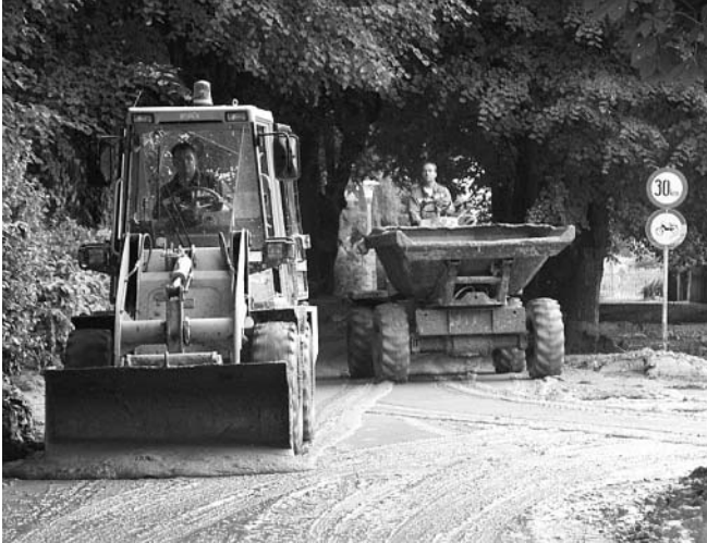
Ein Teil der Räumbrigade mit schwerem Gerät im Einsatz.
