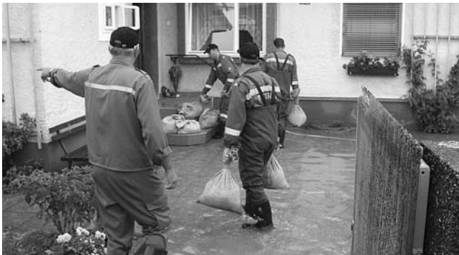
Eine der Hauptaufgaben der Feuerwehr in der Anfangszeit war das Befüllen und Auslegen der Sandsäcke.
