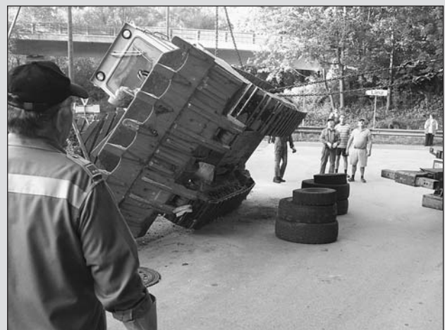
Nur durch die Mithilfe eines Kranfahrzeuges konnte der Bagger wieder aufgerichtet und verladen werden.
