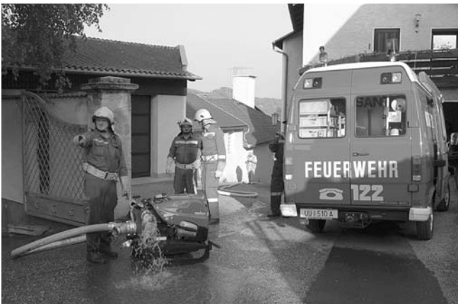
Eine Zubringerleitung musste von der Donau bis zum Tabor verlegt werden.
