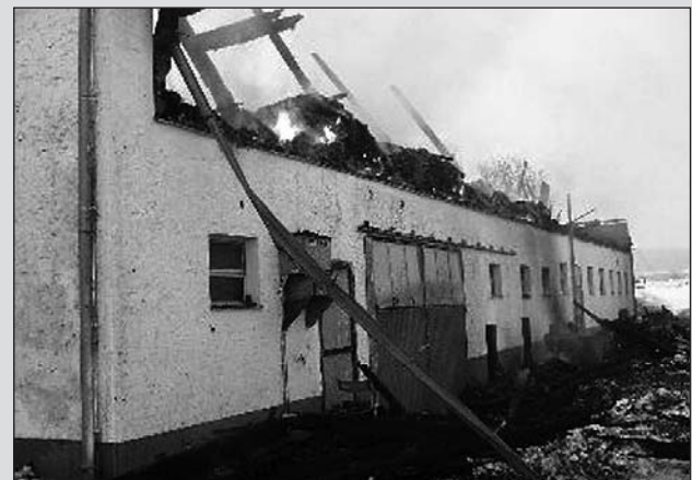
Der abgebrannte Teil des Bauernhauses mit dem darunter liegenden Stall, in dem die Tiere auch während des Einsatzes belassen wurden.
