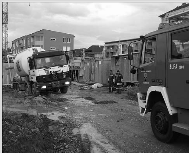
Die Bergung des LKW mit der Einbauseilwinde führte noch nicht zu dem erhofften Erfolg
