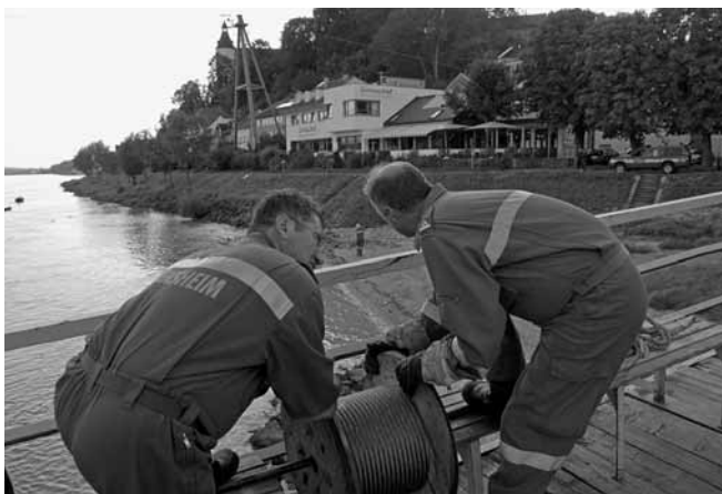
Franz Grilnberger und Kurt Kainerstorfer sicherten das Seil auf der Brücke zur Fähre.
