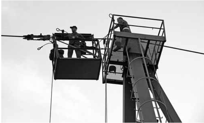
In luftiger Höhe sind die Arbeiten zum Wechseln des Gierseiles zu verrichten.
