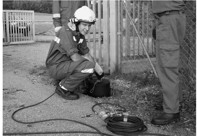
Um ein Eindringen von umweltgefährdenden Flüssigkeiten in das Kanalsystem zu verhindern, mussten die Schächte mittels Dichtkissen verschlossen werden.
