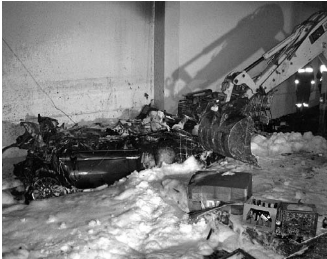
Die Betonteile der Seitenwand mussten vor dem Bergen des Unfallfahrzeugs erst mit einem Bagger entfernt werden.
