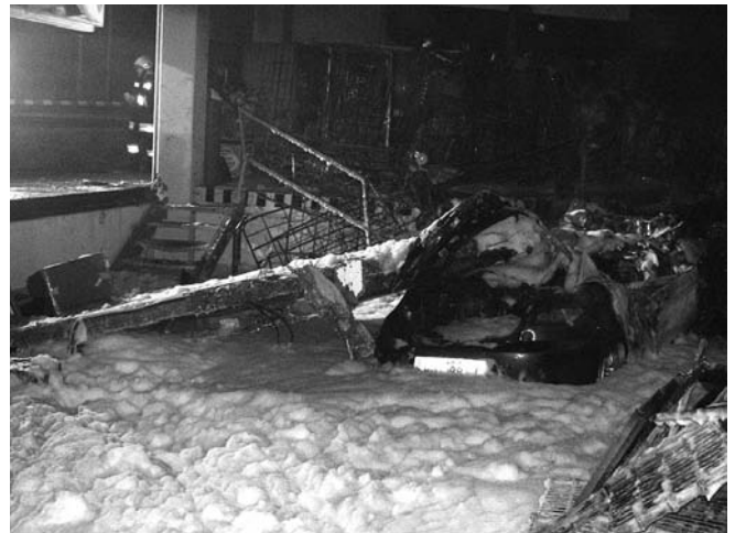
Ein ganzes Element der Seitenwand aus Beton wurde vom Fahrzeug durchstoßen und ins Innere geschleudert. Im Außenbereich befanden sich keine Betonteile.
