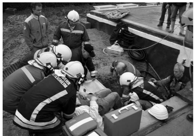
Gemeinsam mit dem Notarzt wurde der verletzte Bauarbeiter aus seiner misslichen Lage befreit.
