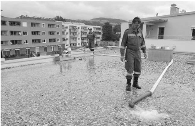
Um es auf Dichtheit zu prüfen, mussten 12.000 Liter Wasser mit der Tragkraftspritze auf das Flachdach gepumpt werden.
