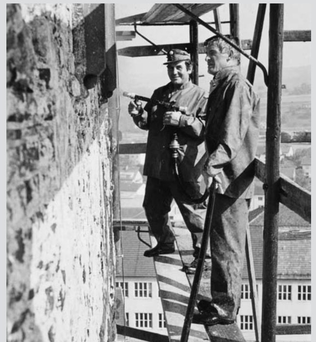
Adi Pargfrieder und Josef Klaubauf hoch droben am Kirchturm wuschen den losen Putz mit dem HD-Rohr ab.
