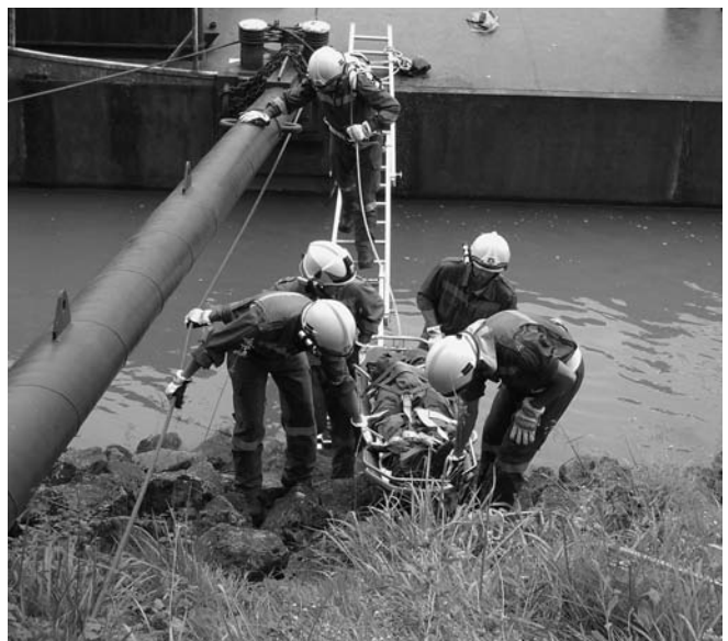
Das Bauen eines Hilfsstegs, von dem man das Schiff mit der verletzten Person verlassen konnte, war eine der Aufgaben.
