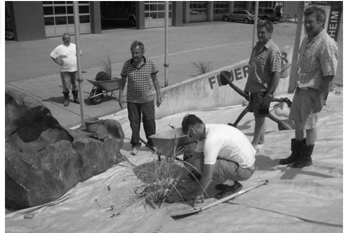
Bevor der Granitbruch aufgebracht werden konnte, wurde ein Flies ausgelegt und die neuen Pflanzen gesetzt.
