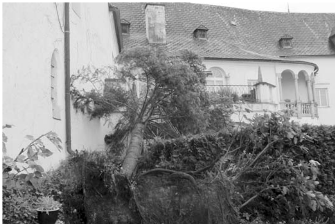
Bei einem kurzen aber heftigen Sturm fiel dieser Nadelbaum auf die Terrasse und beschädigte auch Teile des Daches.
