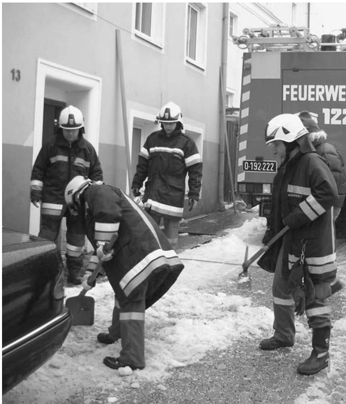
Der richtige Absperrschieber musste erst gesucht und von Eis und Schnee befreit werden, um den Wasserzufluss zu stoppen.
