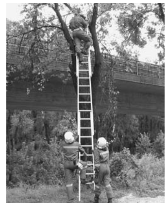
Während dem Arbeiten auf der Leiter wird diese von 2 Kameraden gesichert.
