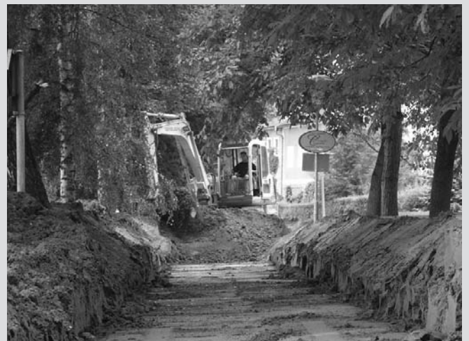
Der Schlamm war überall, aber im Bereich der Schiffsanlegestelle und der Sportanlagen gab es die meisten Ablagerungen.
