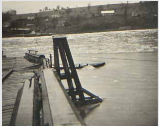
Das versenkte Standschiff und der abgerissene Anlegesteg.
