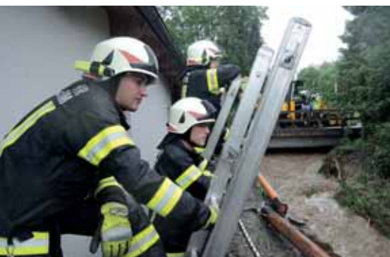
Die Hochwassersperre wurde auf der Brücke aufgebaut, um für das Schlimmste gesichert zu sein.
