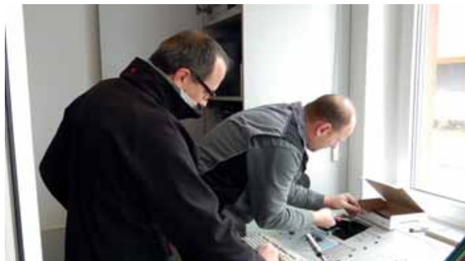
Ein Bedienteil der Anlage wird in der Zentrale installiert.
