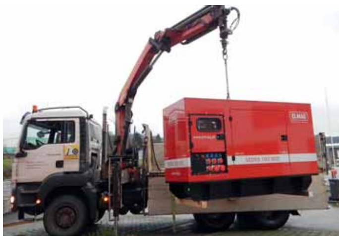
Das Notstromaggregat, welches ab nun einen Betrieb des Hauses auch bei Katastrophenfällen sicher stellt, wurde dankenswerter Weise durch die Fa. Leithäusl angeliefert.
