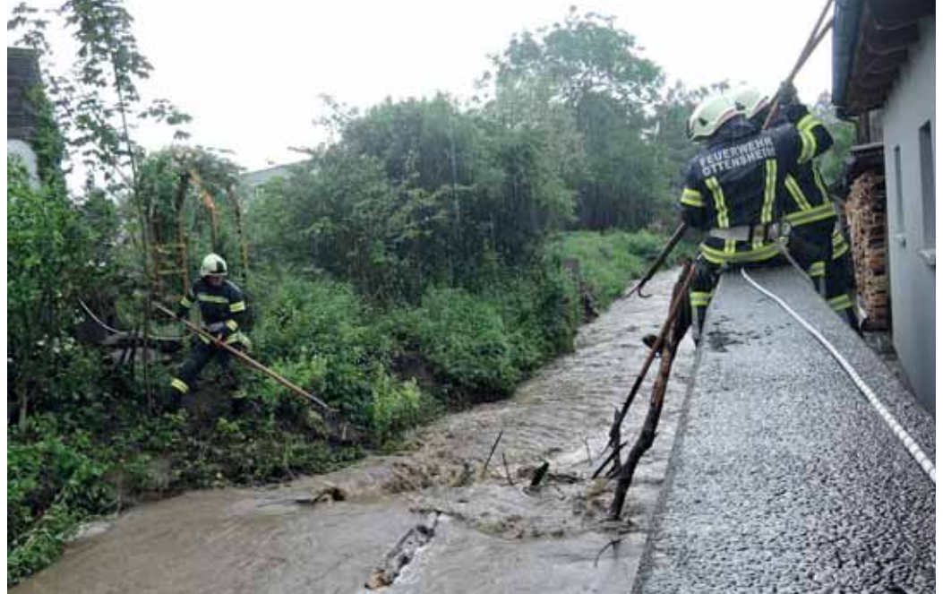
Mit den Einreißhaken wurde versucht, die festsitzenden Baumstämme wieder frei zu bekommen, um ein freies Abfließen zu gewährleisten.
