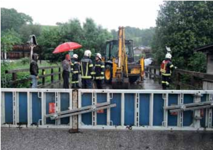
Die Hochwassersperre wurde auf der Brücke aufgebaut, um für das Schlimmste gesichert zu sein.
