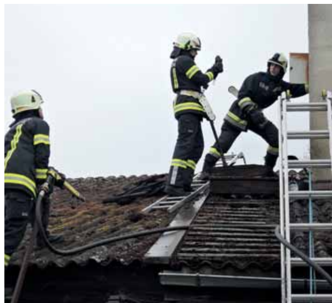
Daniel Rechberger und Patrick Aigner kontrollieren nach den Löscharbeiten die Brandausbruchsstelle und den Kamin mit der Wärmebildkamera.
