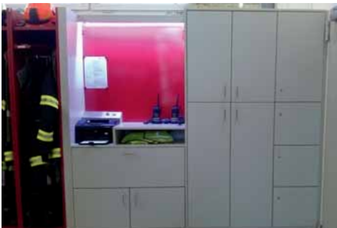
Die neue Außenstelle der Zentrale in der Fahrzeughalle.
