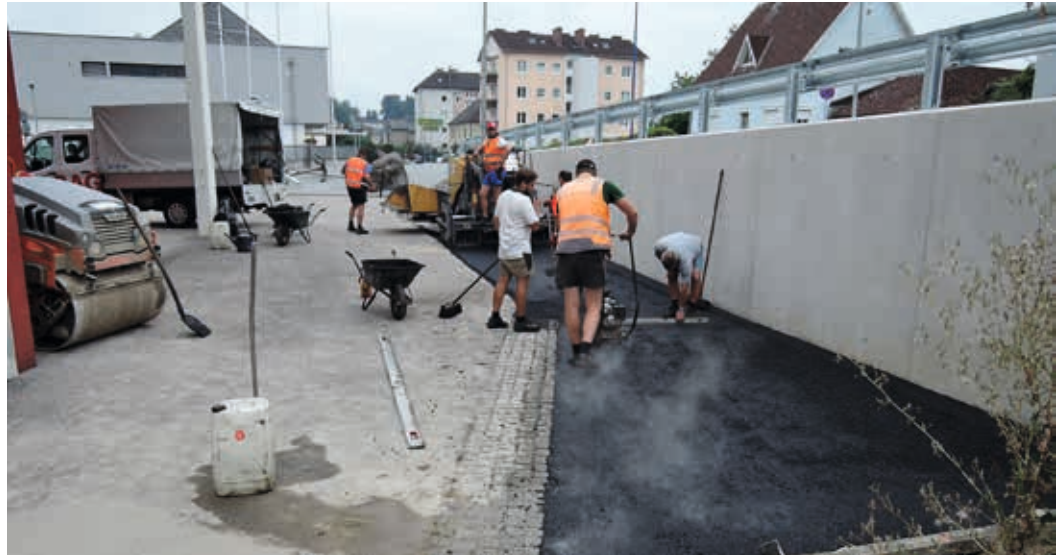
Eine Stützmauer bildet jetzt den Abschluss zur Bahnhofstraße und der neu errichteten Abbiegespur.
