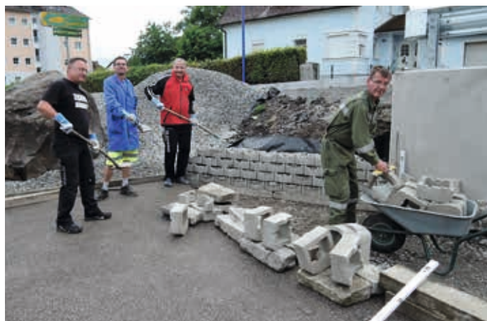
Um einen ordentlichen Abschluss zur Mauer zu bekommen, kaufte die Feuerwehr Löffelsteine und versetzte diese in Eigenregie.
